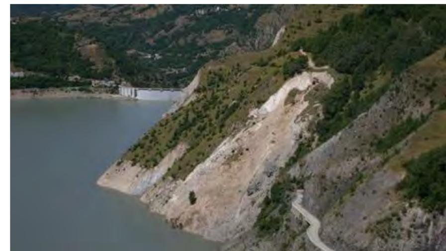
Figure 39 : Glissement de terrain au niveau du tunnel du Grand Chambon - Source Département de l'Isère
