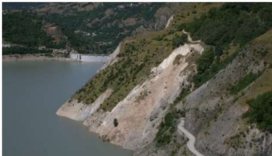
Figure 37 : Glissement de terrain au niveau du tunnel du Grand Chambon - Source Département de l'Isère
